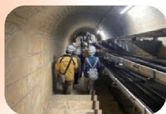
ダム堤体階段
