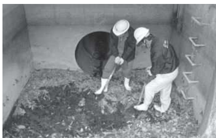
水路内の排泥除塵作業
