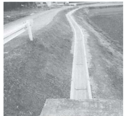
【R5実施：水路補修整備】
