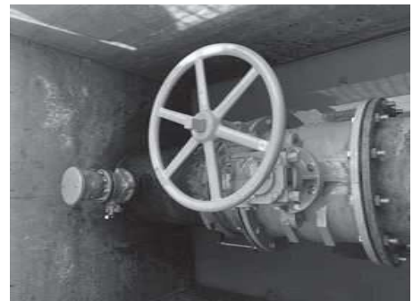
【R5実施：バタフライ弁整備】
