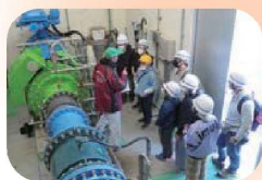
小水力発電所
