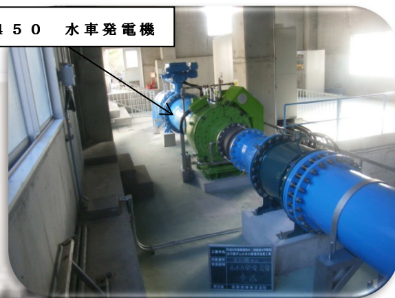
発電機設置状況
