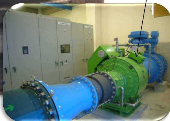
発電機設置状況
