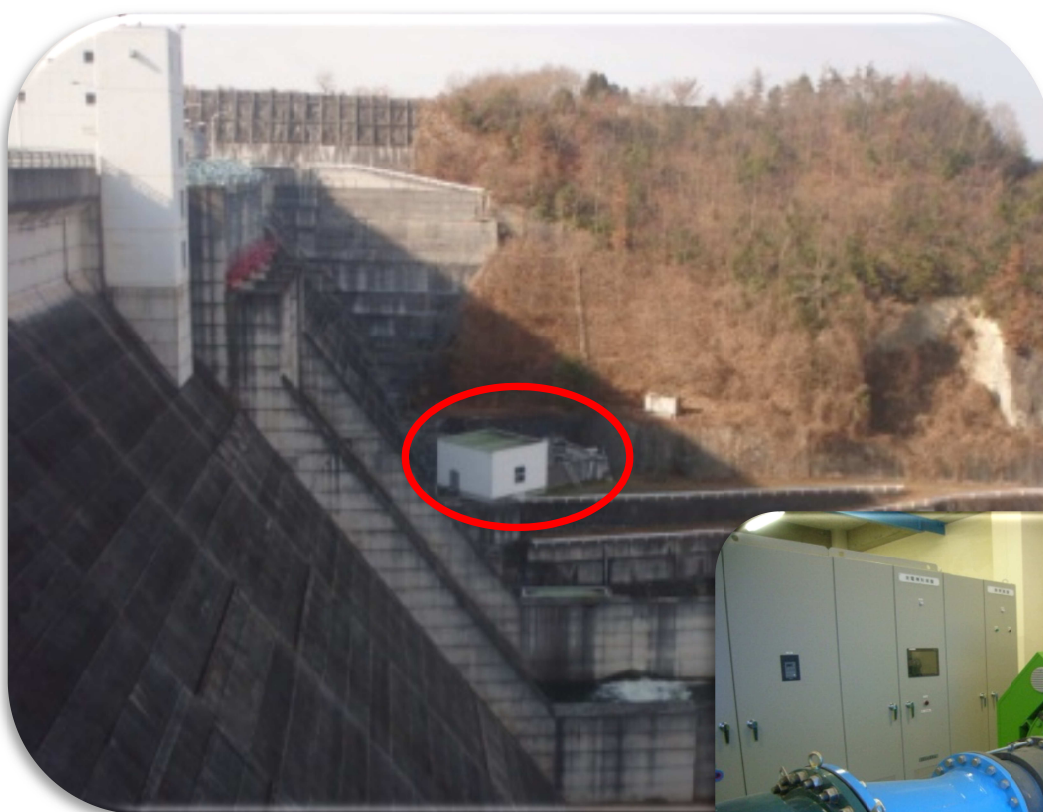
設置場所：中央幹線放流工室
